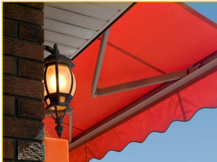
Se pretează îndeosebi la acoperirea spațiilor ce aparțin balcoanelor, curților interioare de mici dimensiuni sau oricărora alte zone unde este necesară o soluție de acoperire care să nu deranjeze circulația pe dedesubt sau acolo unde o copertină cu braț basculant nu poate fi montată.
